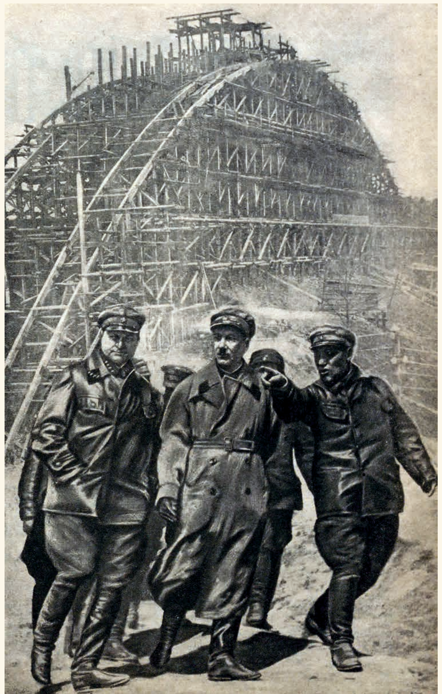
Начальник Дмитлага С. Фирин, нарком НКВД Г. Ягода и начальник Хлебниковского района Г. Афанасьев на строительстве Химкинского железнодорожного моста.
