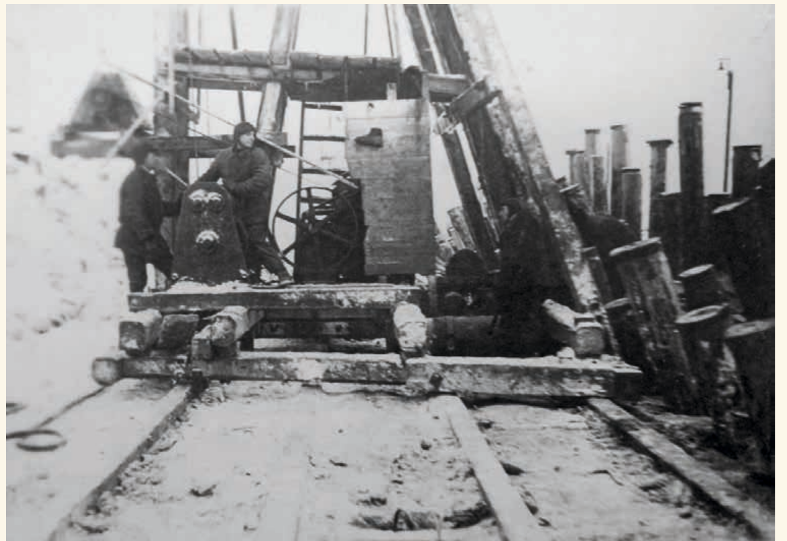
Забивка свай (будущий причал Северного речного вокзала).
