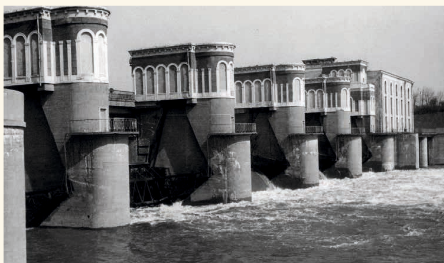
Водосбросная плотина в Карамышево, Москва.
