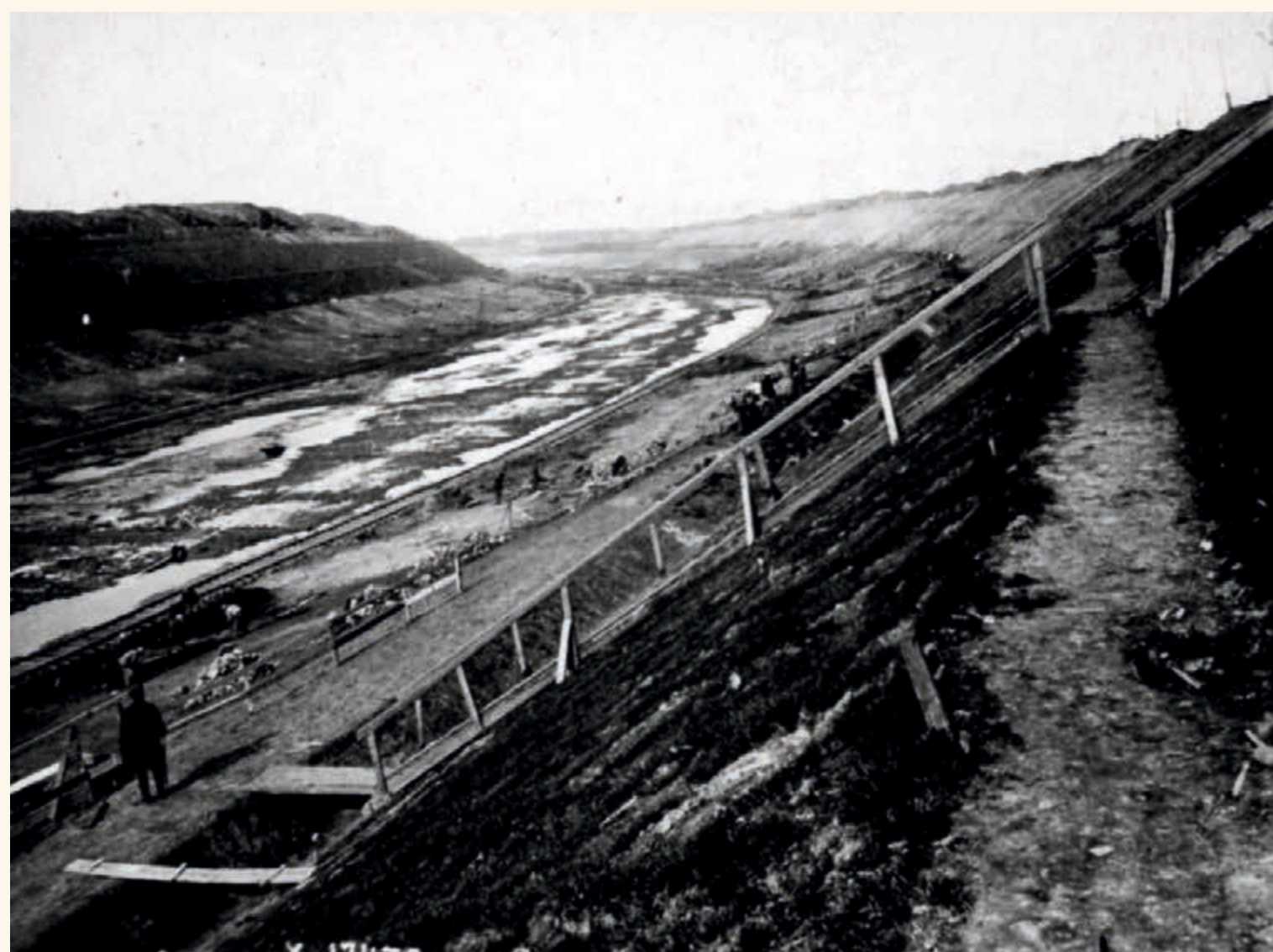
Сталинская лестница на Глубокой выемке.
