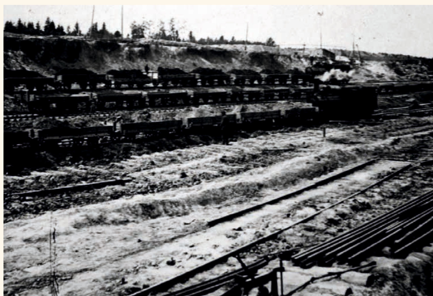
Железнодорожные пути в Глубокой выемке.
