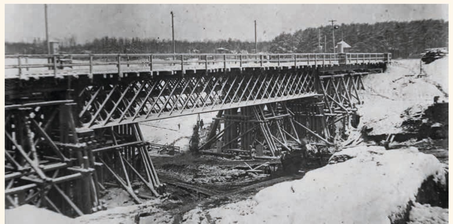
Строительство Химкинского железнодорожного моста. Вид с востока.
