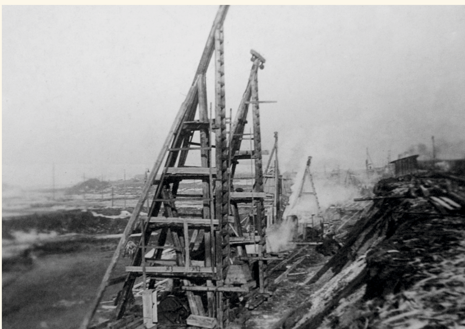
Паровые копры (снаряды для забивки свай в грунт).
