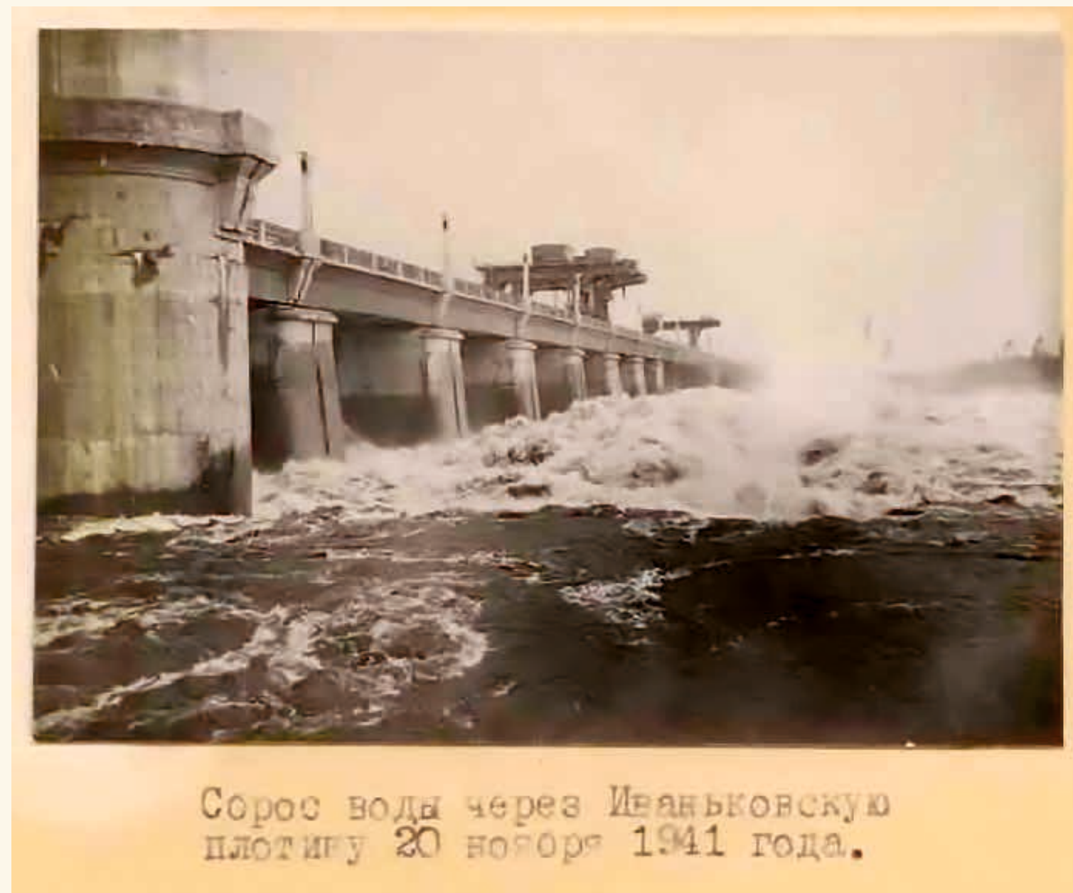
Сброс воды через Ивановскую плотину, 20 ноября 1941 г.
