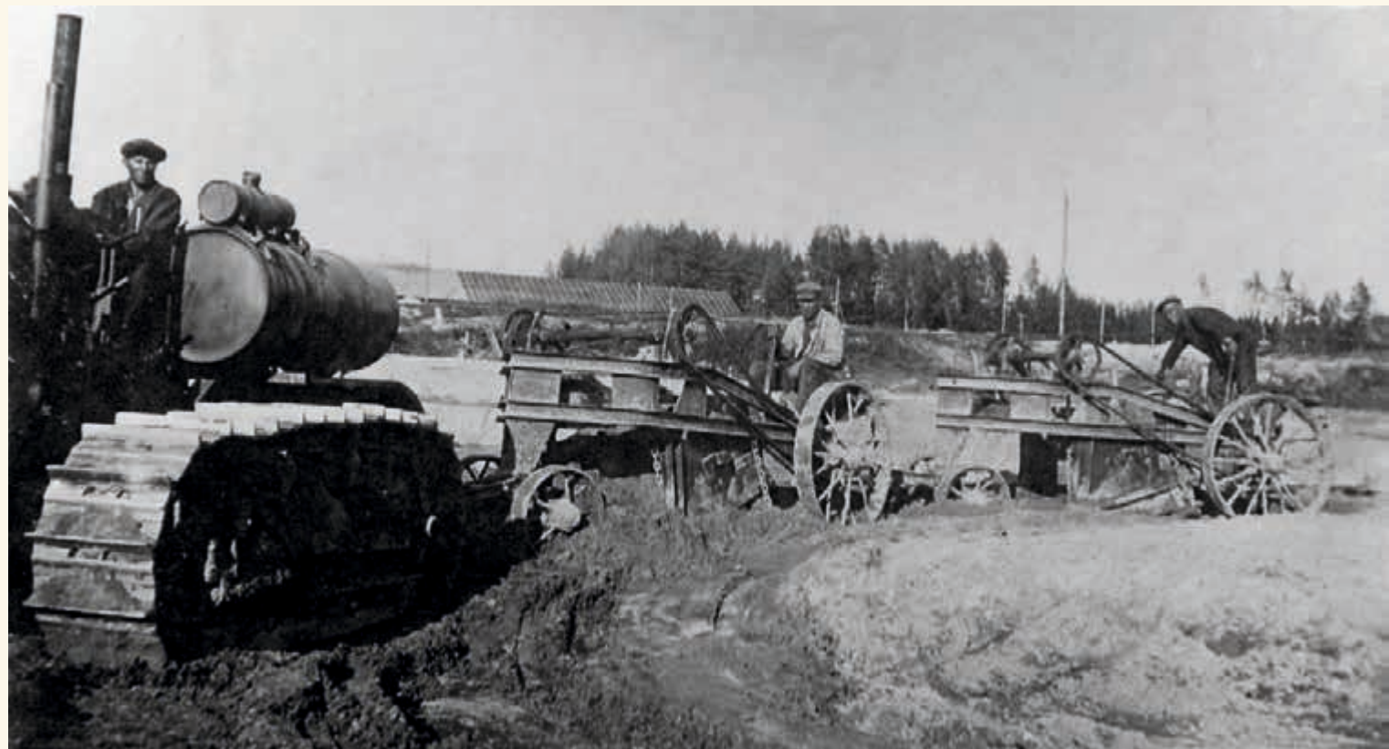
Отсыпка и укатка дамб.
