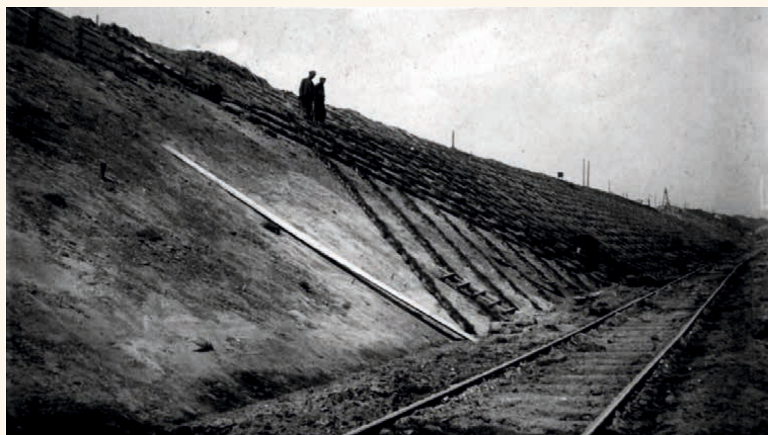
Одерновка (укрепление дерном) откосов Глубокой выемки.
