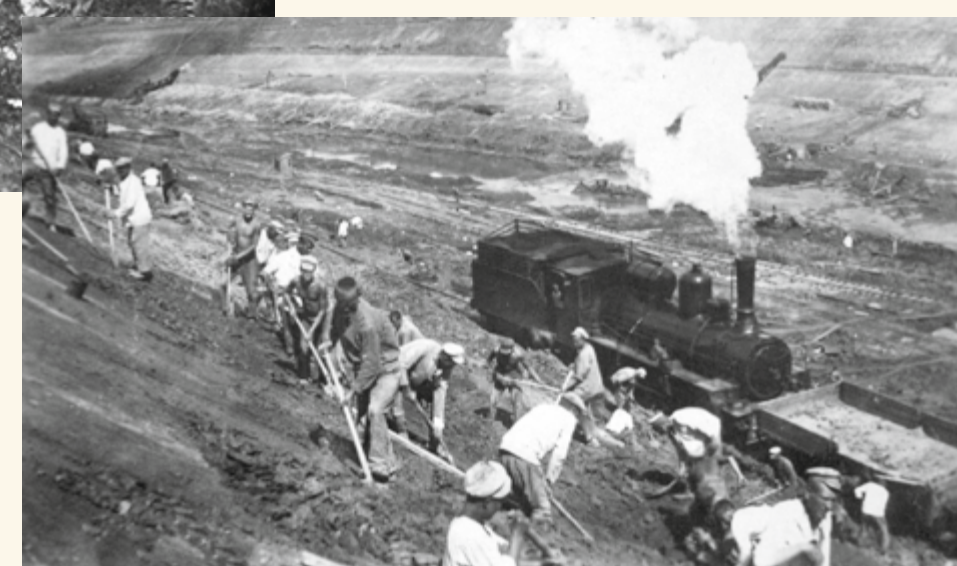
Зачистка откосов Глубокой выемки.
