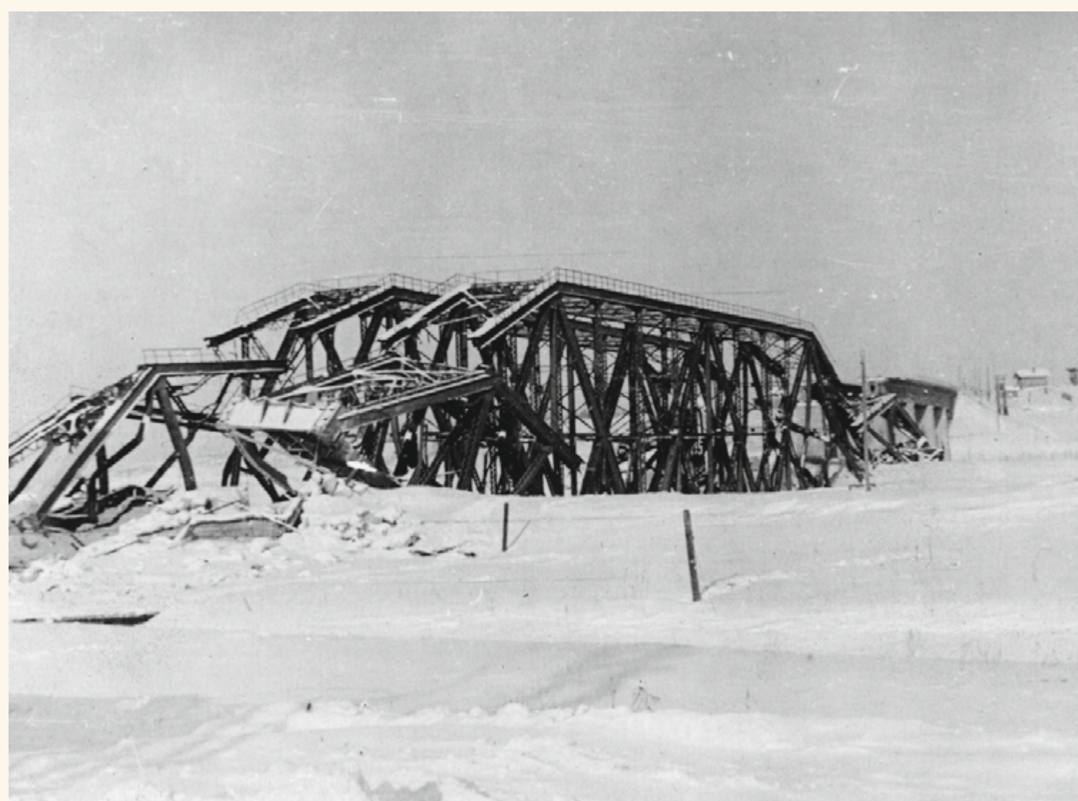
Железнодорожный мост на перегоне Яхроме-Турист после взрыва. 29 ноября 1941 г.
