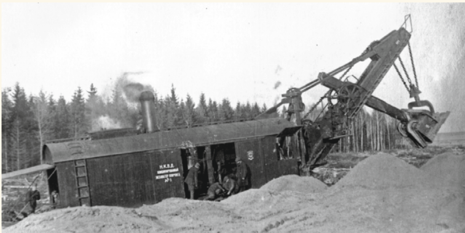
Испытания первого экскаватора «Ковровец» на гусеничном ходу, Хлебниковский район.
