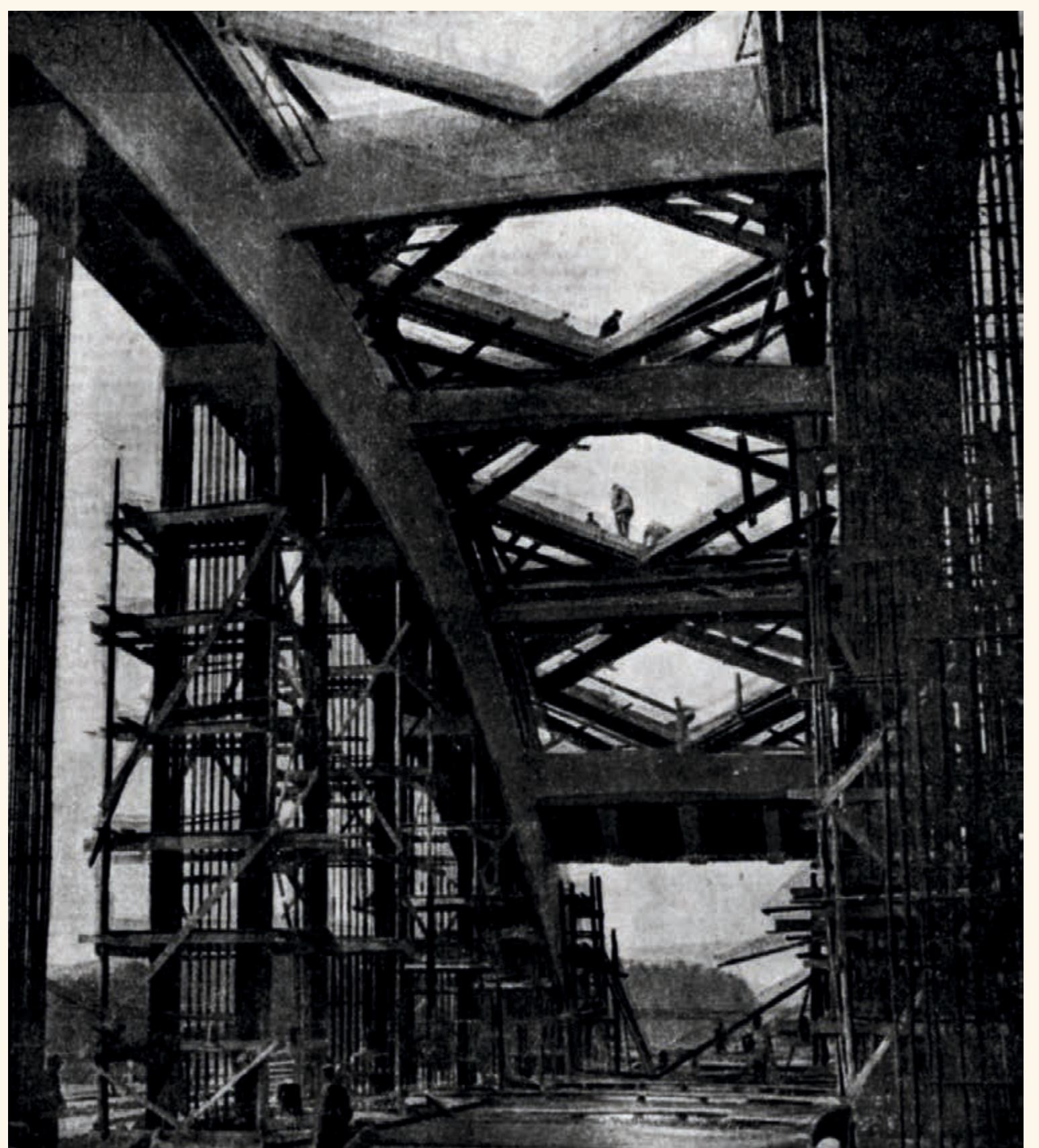
Завершение строительства Химкинского железнодорожного моста, октябрь 1935 г.
