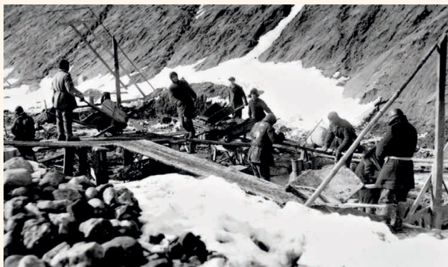
Укладка камня для фильтра, 1935 г.
