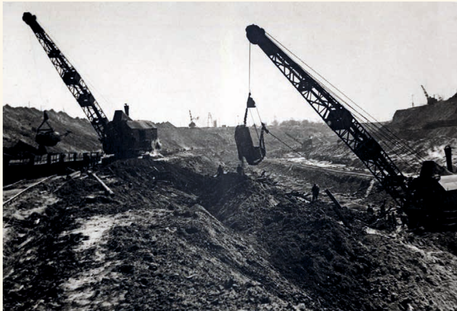
Экскаваторы ППГ на Глубокой выемке.
