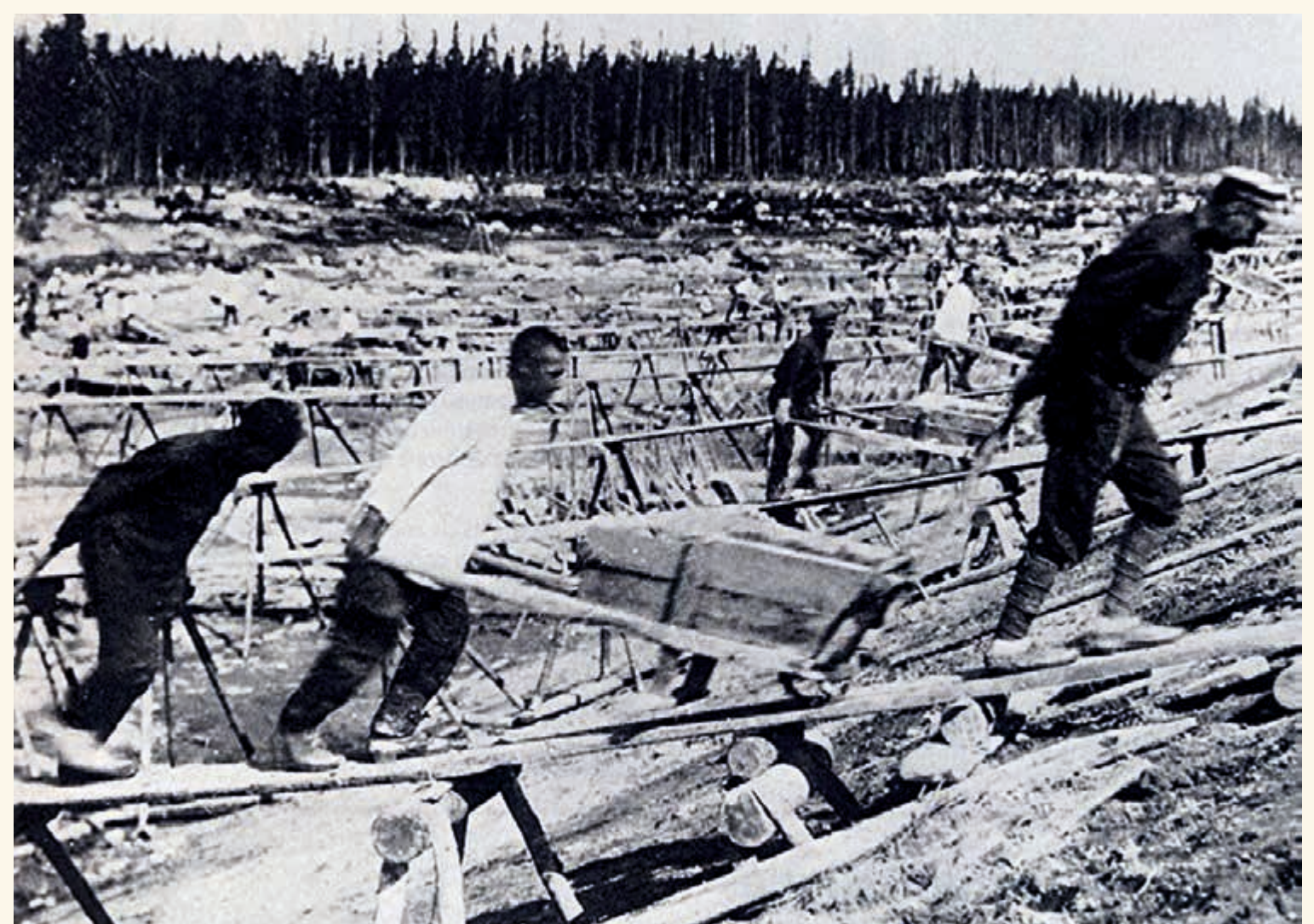
Тачечная возка при помощи крючника.
