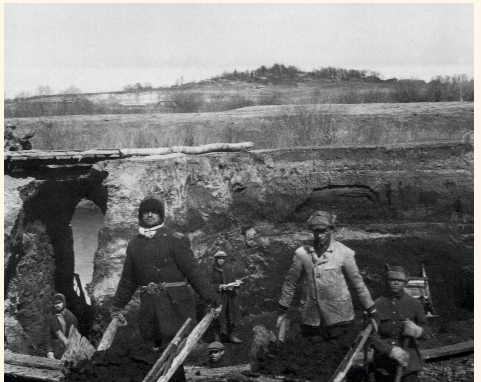
Земляные работы. Хлебниковский район.
