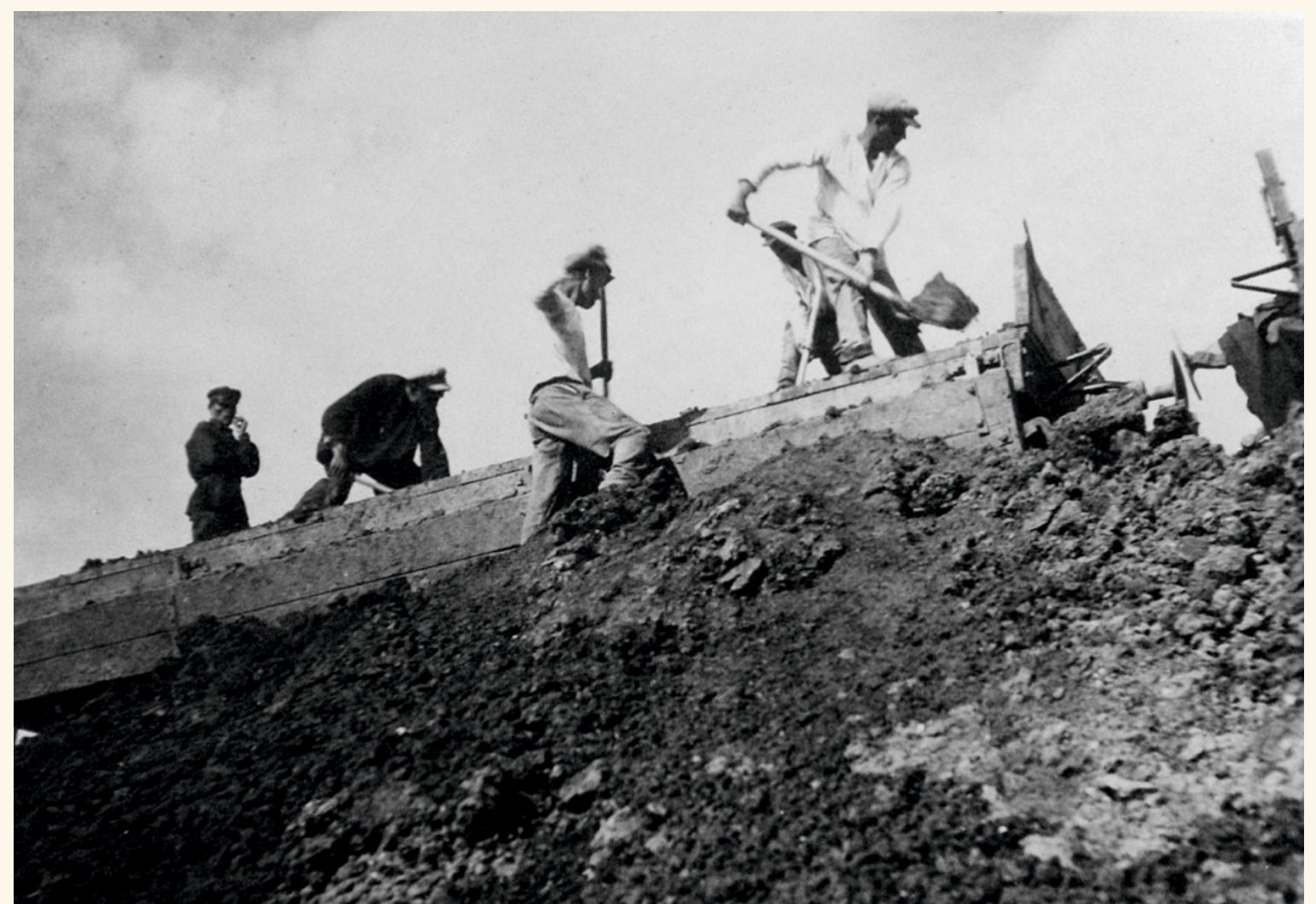
Разгрузка грунта с платформ.
