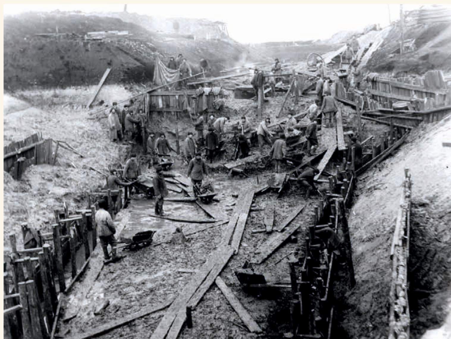
Работы по дополнительной выемке грунта, 1935 г.
