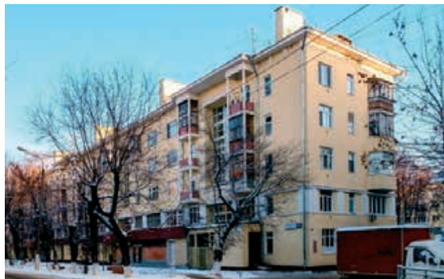
Фото 2. Дом 8/5 по ул. Бурденко, бывший дом 2А.
