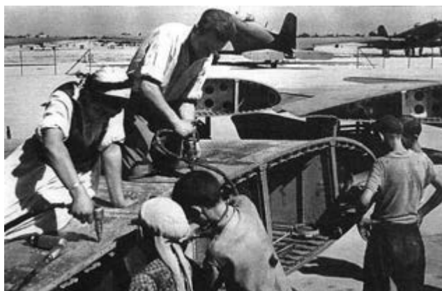
Рис. 5. Сборка Ли-2 на Ташкентском заводе №84 в годы войны.
