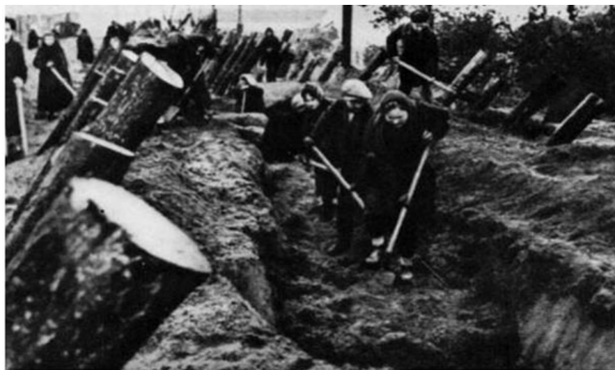
Рис. 3. Строительство линии обороны. Женщины и дети вкапывают на метровую глубину толстоствольные дубовые противотанковые надолбы.
