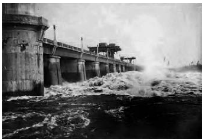
Рис. 3 Сброс воды через Иванововскую плотину 20 ноября 1941 г.
