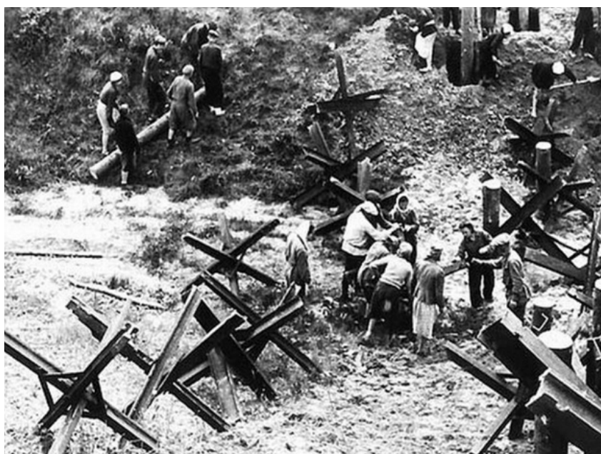
Рис. 4. Строительство линии обороны. Противотанковые ежи устанавливали не только на берегу, но зимой и на льду канала Москва - Волга.
