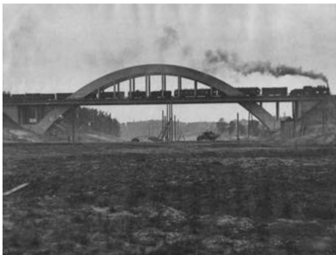
Русло канала до заполнения водой
